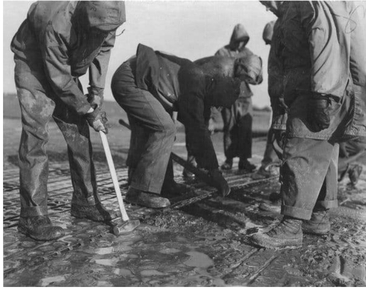
IMAGEN 1.2 ENSAMBLE DE ESTERAS MARSTON
