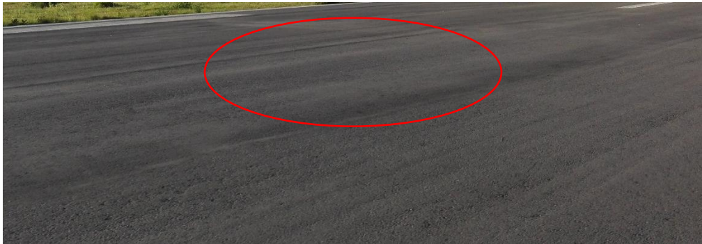
Imagen 7.2.2 Abultamiento en una pista
