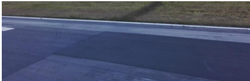
Imagen 7.3.3 Parches en áreas de movimiento de aeronaves.
