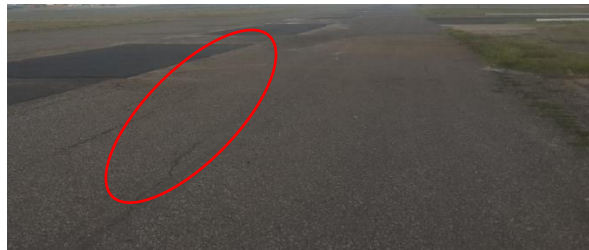
Imagen 1, Falla Longitudinal
