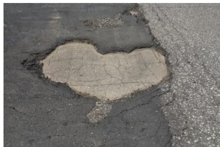
Imagen 7.3.2 Bache en áreas de movimiento de aeronaves
